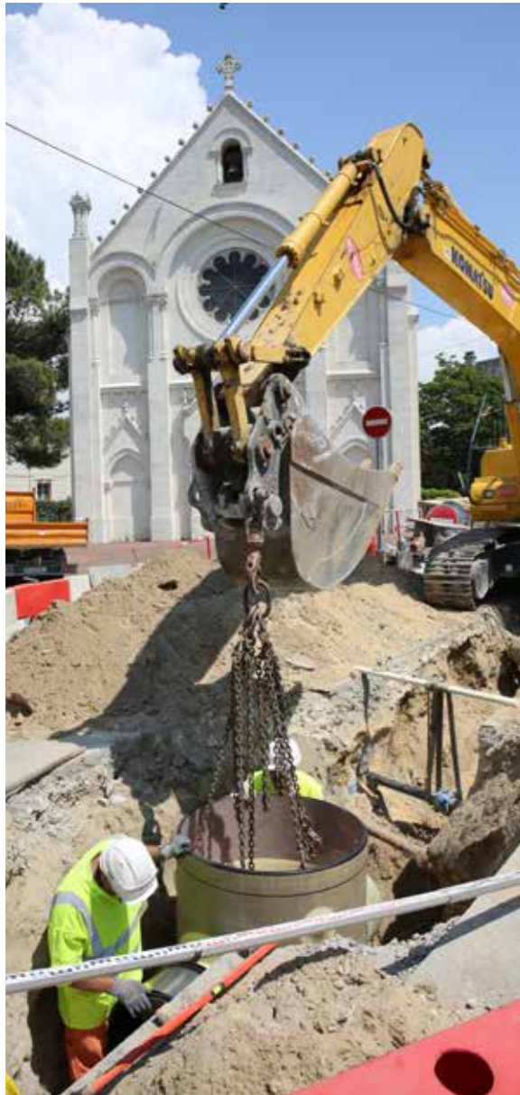
À Royan, les travaux de l'avenue de Paris seront interrompus pendant l'été
