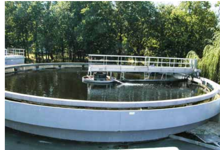
La construction d'une nouvelle station d'épuration à La Tremblade fait partie des actions programmées dans le nouveau schéma directeur
