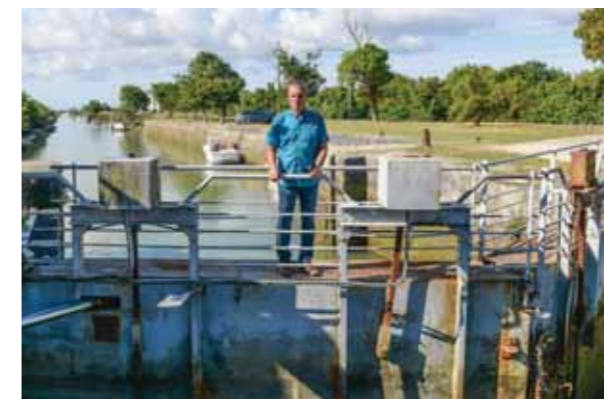
Le remplacement de la porte-écluse du port de Marennes parmi les investissements prioritaires
